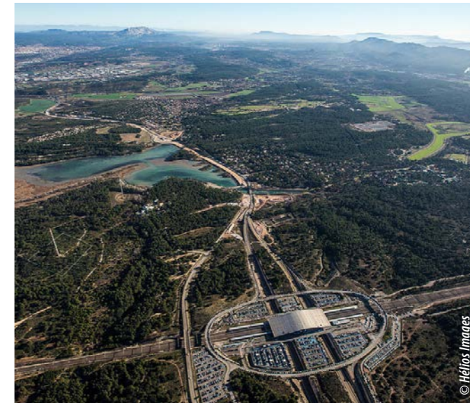
GARE TGV ET BASSIN DE RÉALTOR (AIX-EN-PROVENCE)
