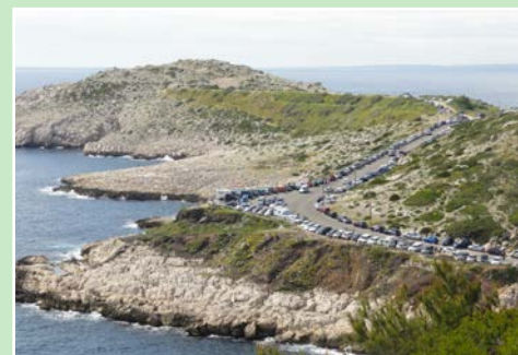
Porte d'accès peu lisible, créant des zones de tension en lien avec la gestion des flux et l'organisation du stationnement
