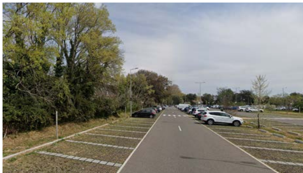
Parking perméable - Village des marques Miramas
